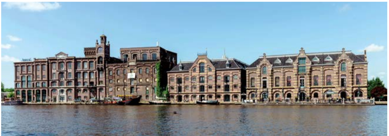
Detail entree De Zaanbrug De Rijksmonumentale Zaanwand
